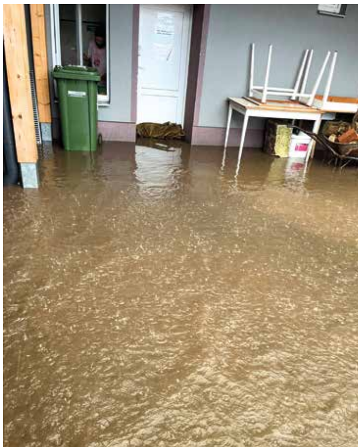
Při průtrži hasičkou protékal potok vody.
