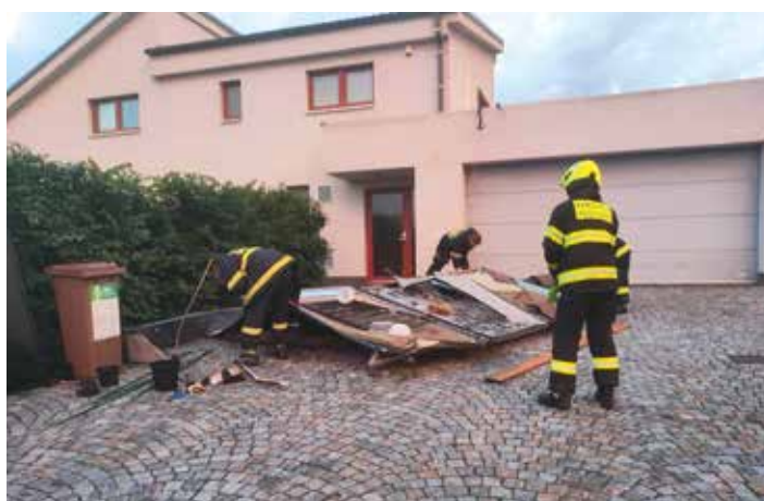
Hasiči uklidili vichřicí poškozenou fotovoltaiku.
