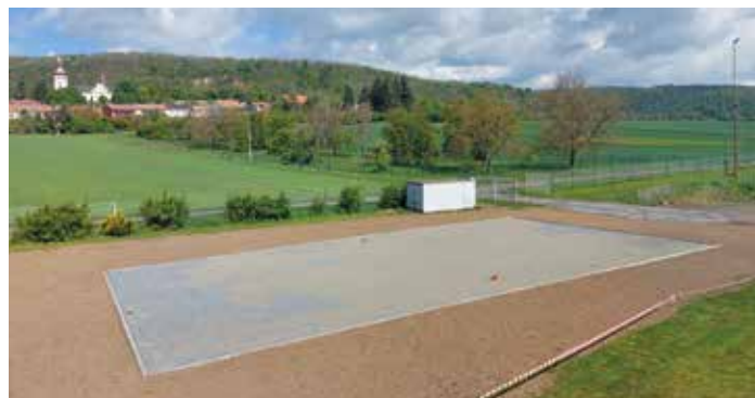
Zemní práce jsou téměř hotové.
