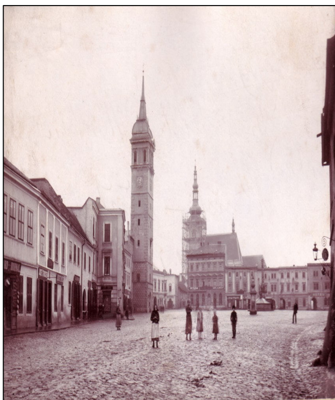
▲ Nově vystavěná budova První kontribučenské záložny ve Vyškově, otevřená 5. července 1885.
