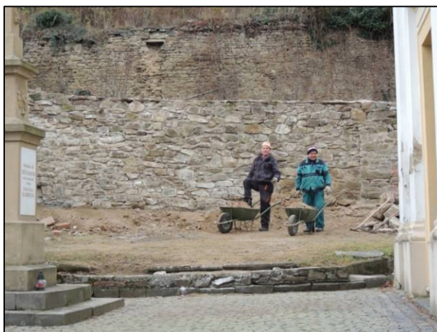
▲ Dočišťovací práce provedli zaměstnanci Obce Pustiměř. Urovnali terén kolem stavby a odvezli traktorem přebytečnou hlínu. Na obrázku zleva Jan Raclavský a Vladimír Konečný. Foto: Anna Hrozová.
