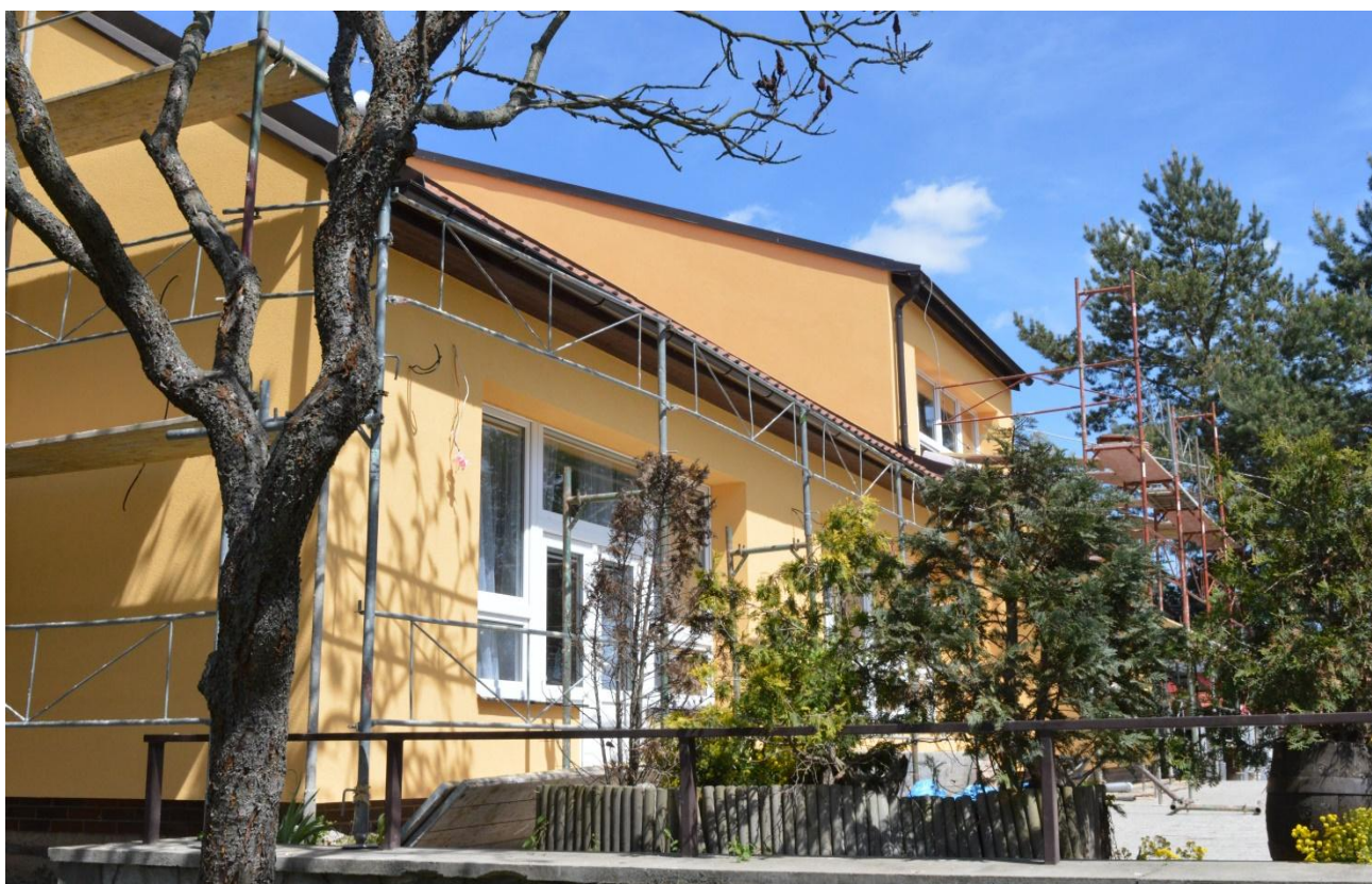
Obrázek 85: Zateplení a výměna oken a dveří na Adélce.
