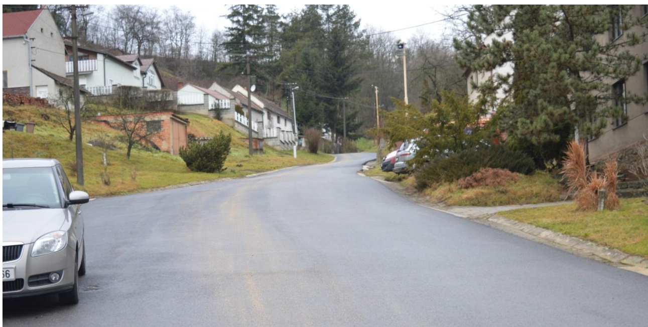
Obrázek 84: Nový asfaltový povrch v Horním Buchtále.
