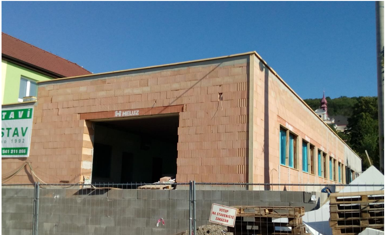
Obrázek 124: Přístavba mateřské školy pod střechou.
