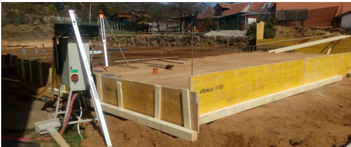
Obrázek 121: Příprava základové desky přístavby školky.
