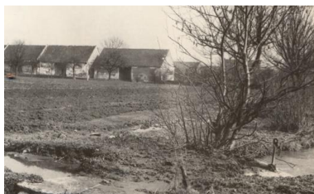
Obrázek 106: Neregulovaný Pustiměřský potok se při každém větším dešti vyléval z koryta.
