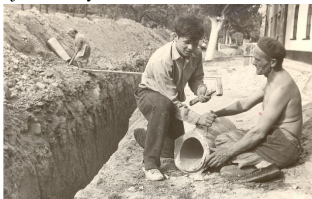
Obrázek 112: Při pokládání kanalizace pomáhaly celé rodiny.
