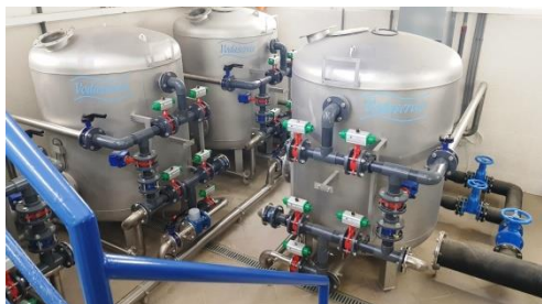
Obrázek 136: Úpravna vody odstraňuje nebezpečné množství manganu v pitné vodě.
