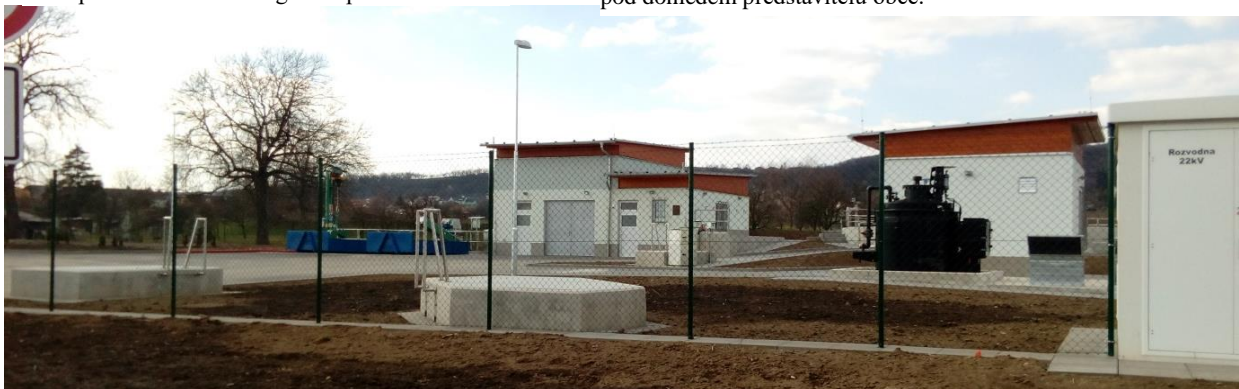
Obrázek 136: Úpravna vody odstraňuje nebezpečné množství manganu v pitné vodě.
