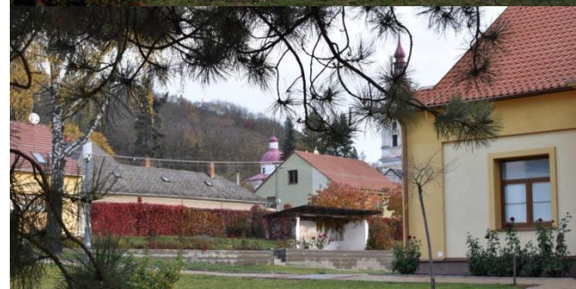
Obrázek 119: Obec tak získala pěkný kulturní a sportovní stánek, do něhož mimo jiné byla namontována lezecká stěna, na níž bylo při rekonstrukci pamatováno. Na místě kuželny, která byla v havarijním stavu, vzniklo pěkné zákoutí.
