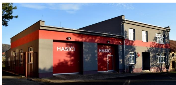
Obrázek 125: Byla zateplena Hasičská zbrojnice.
