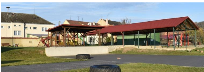
Obrázek 134: Střeška na bývalé kůlně za OÚ.
