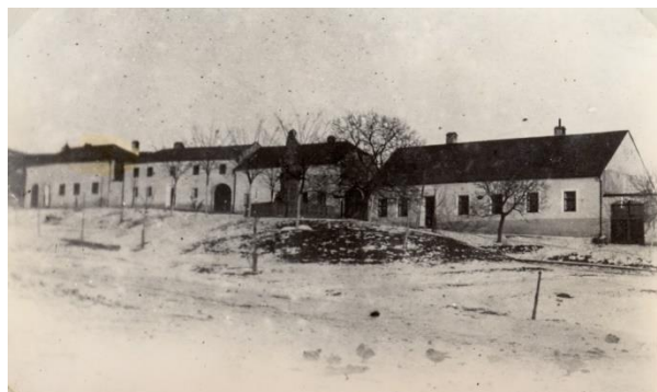
Obrázek 93: Na městečku. Hráz bývalého rybníčka.
