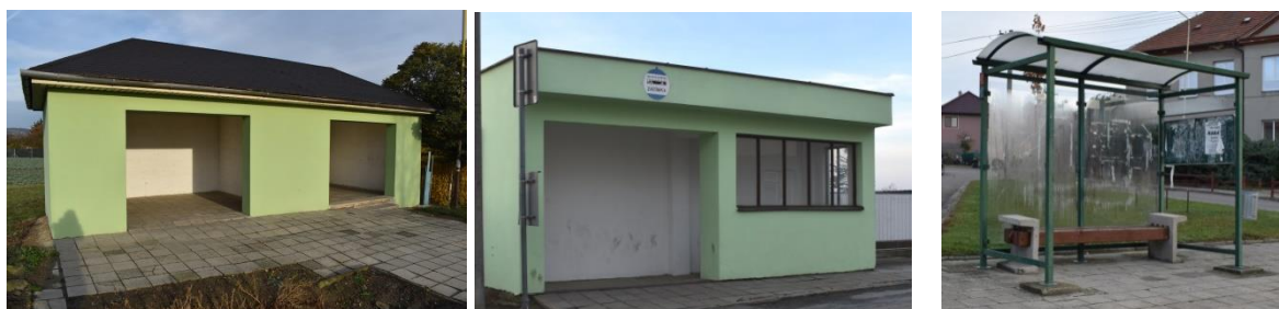
Obrázek 143: Zastávky byly opraveny.
