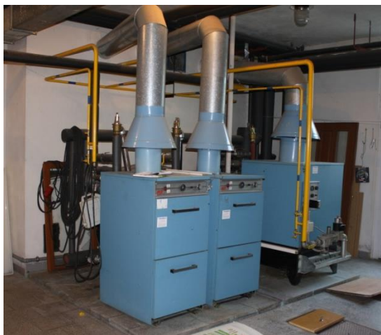
Obrázek 5: Původní kotle v přístavbě "Nové školy". Foto: Lukáš Peška.
