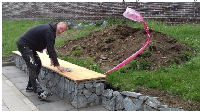
Obrázek 24: Pavel Schweidler usazuje desku lavice na gabionové koše. Foto: Vlastimil Smékal.
