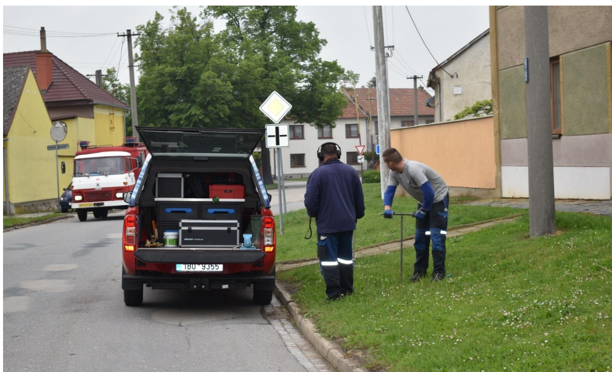
Obrázek 139: VAK Vyškov kontroluje průchodnost podzemního vedení. Foto: Anna Hrozová.
