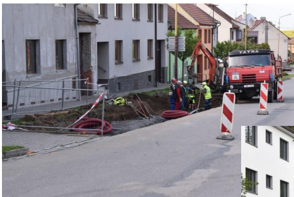
Obrázek 34: V pondělí 6. května začaly stavební práce u pošty. Foto: Anna Hrozová.
