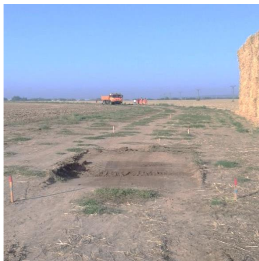
Obrázek 22: Zahájení prací na cyklostezce. Foto: Vlastimil Smékal.
