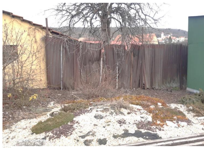
Obrázek 15: Provizorní plechový plot u Maděrového. Foto: Vlastimil Smékal.
