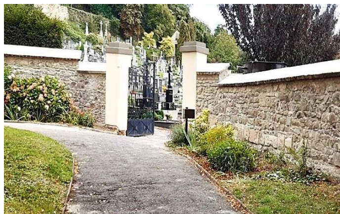
Obrázek 18: Opravený vchod na hřbitov včetně sloupů brány. Foto: Vlastimil Smékal.
