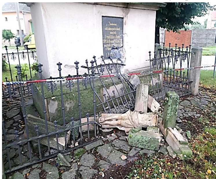
Obrázek 8: Poškozené sousoší Kalvárie. Foto: Vlastimil Smékal.
