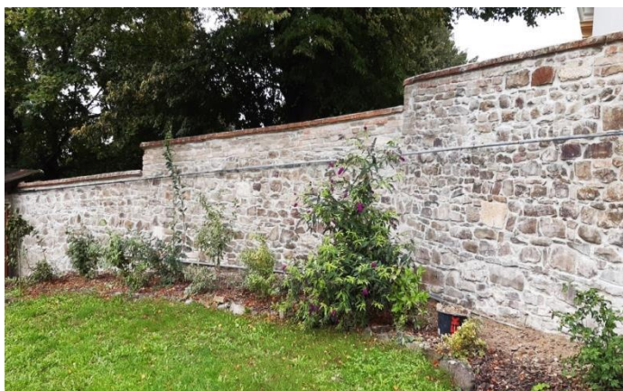
Obrázek 19: Opravená zeď vpravo od vchodu na hřbitov. Foto: Vlastimil Smékal.
