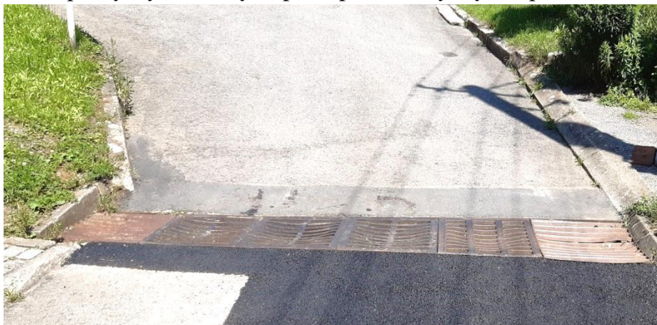
Obrázek 12: Příčná protipovodňová vpusť. Foto: Vlastimil Smékal.
