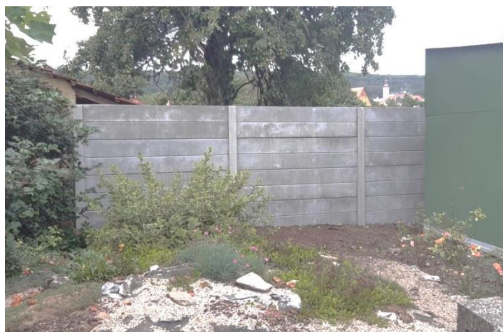
Obrázek 14: Nová betonová zeď. Foto: Vlastimil Smékal.
