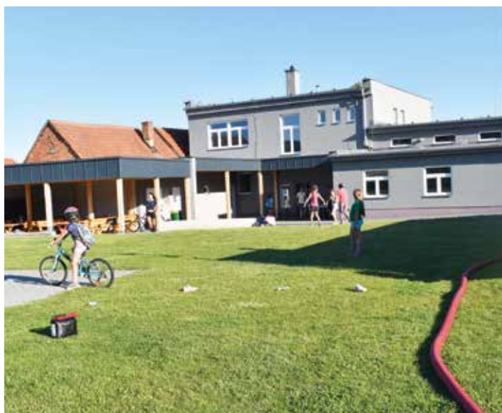
Zateplená hasička se zastřešeným posezením, sociálním zařízením a kioskem. Foto: Anna Hrozová.
