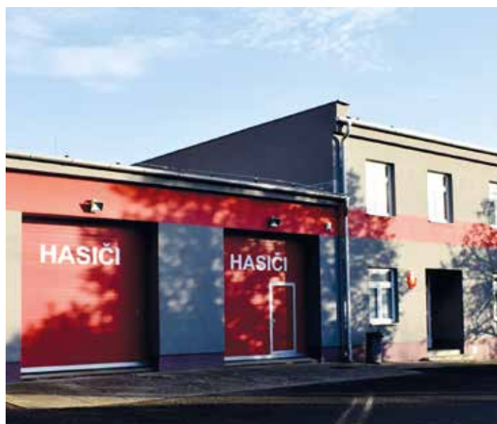
Zateplená hasičská zbrojnice 2016. Foto: Anna Hrozová.
