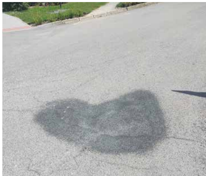
Komunikace po opravě.
