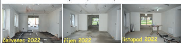
Interiér budoucí knihovny.
